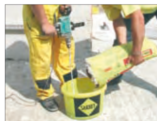
3. Hőszigetelő rendszerragasztó bekeverése.
