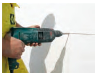
7. Rögzítő dübelek furatainak elkészítése.
