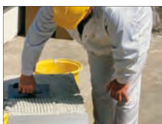
4. A ragasztó felhordása a szigetelő lapra.
