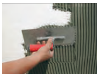
10. Fogazott glettvassal a rendszerragasztó felhordása.
