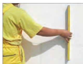
6. A felragasztott felület ellenőrzése.
