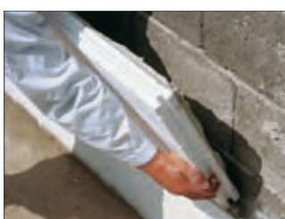
5. A polisztirol lapok felragasztása.
