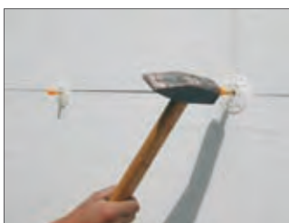
8. Rögzítő dübelek beütése.
