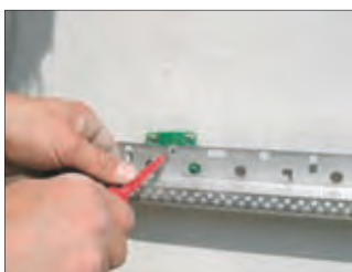
2. Lábazati indítósínek rögzítése.
