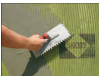
11. Az erősítőháló ragasztóba rögzítése.
